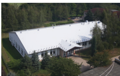
Nová střecha v Rychnově nad Kněžnou
